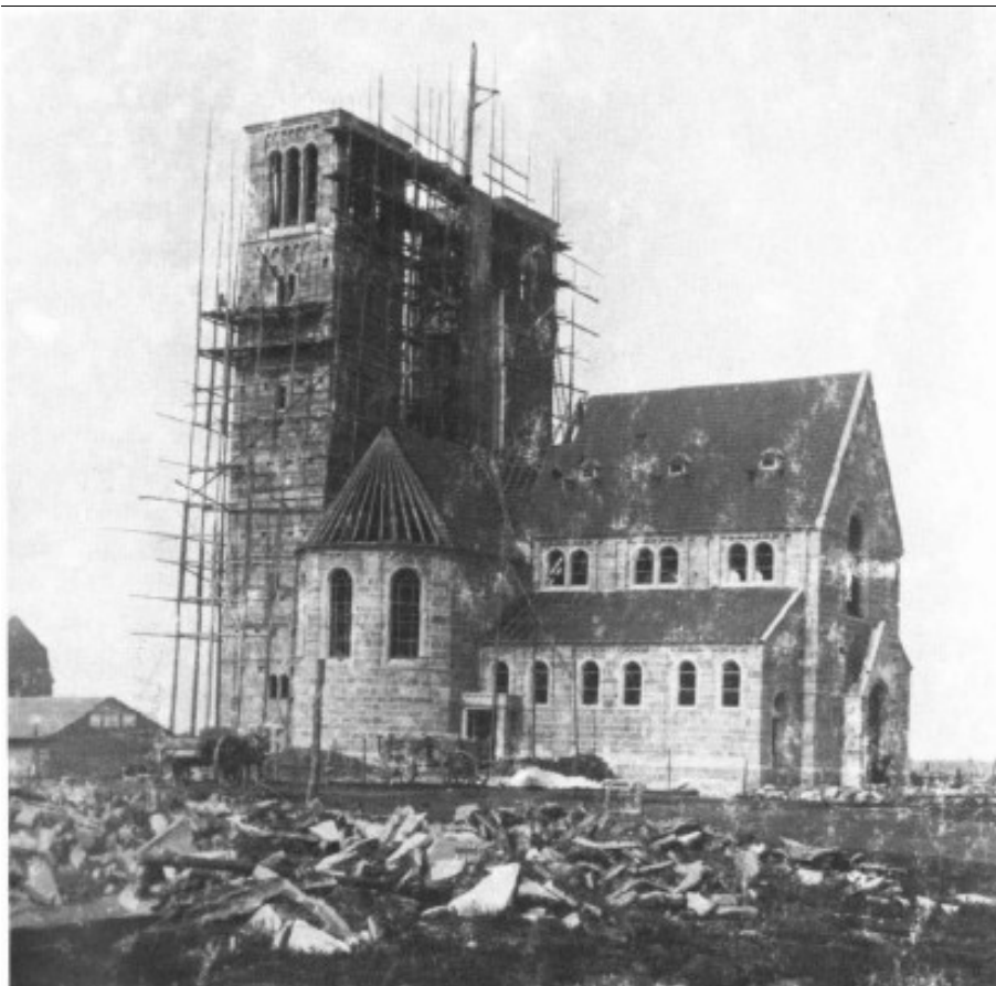
Die Clemenskirche im Bau, aufgenommen 1912.
