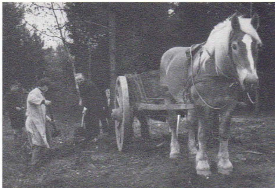
Die Kolpingfamilie hilft bei den Erdarbeiten.
