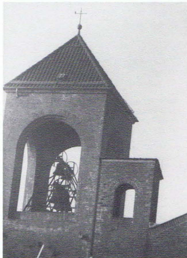
Der Glockenturm im ursprünglichen Zustand
