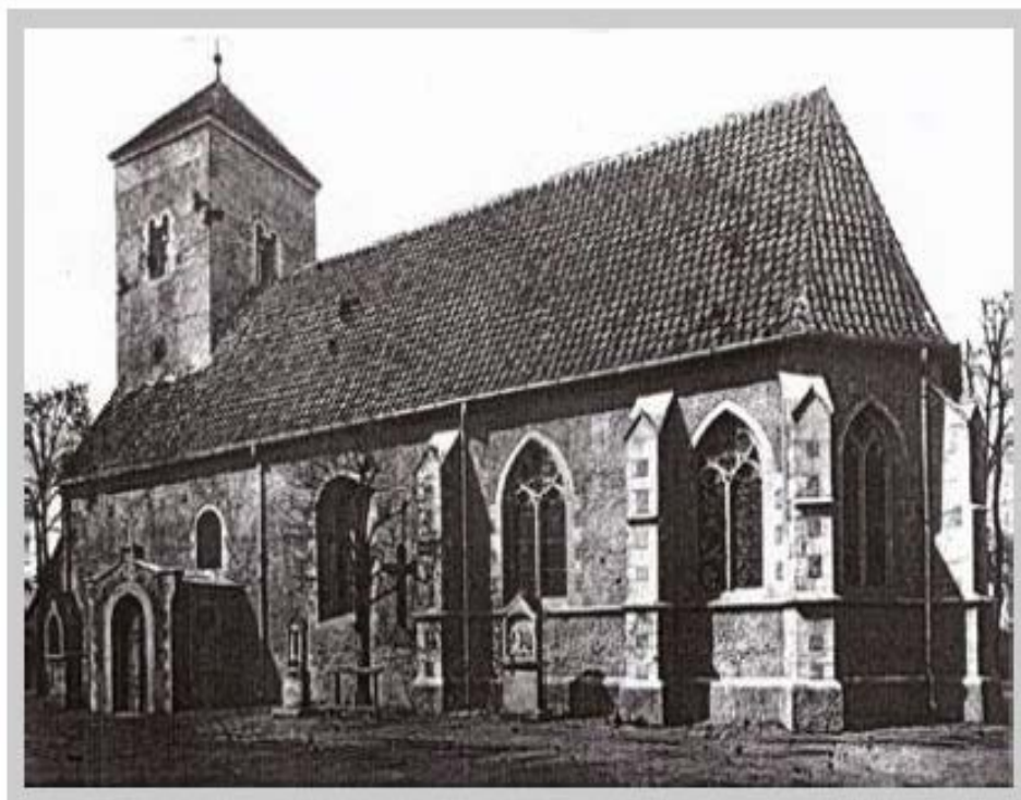
Älteste Foto von 1901 Alt St. Clemens, erbaut im 12. Jahrhundert im romanischen Stil und im 16. Jahrhundert gotisch erweitert.
