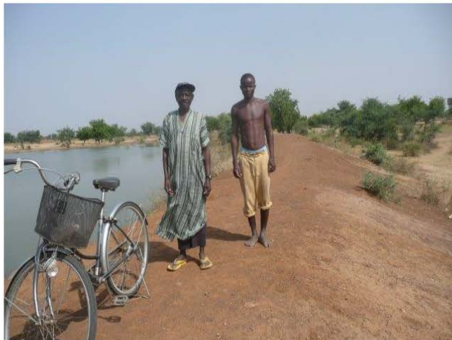
Gang über den Staudamm
