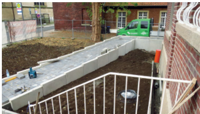
Nimmt Gestalt an: die Rampe für den barrierefreien Zugang
