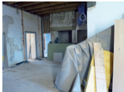
Noch Baustelle: Pfarrheim St. Sebastian
