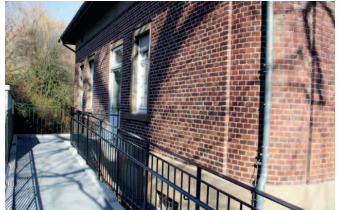
Der barrierefreie Zugang über die Rampe
