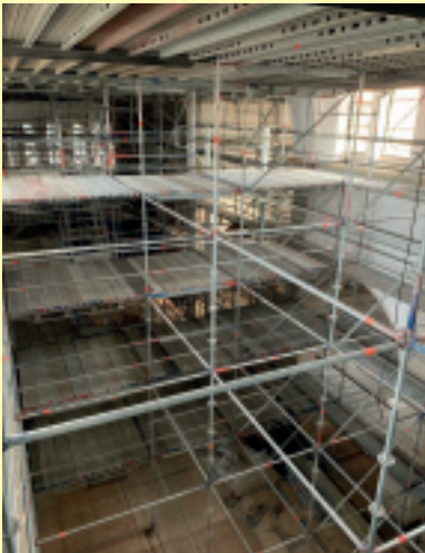
Das Baugerüst mit mehreren Etagen
