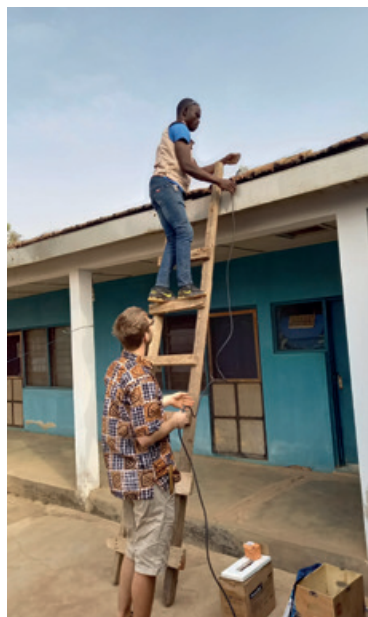
Montage der neuen Beleuchtung
