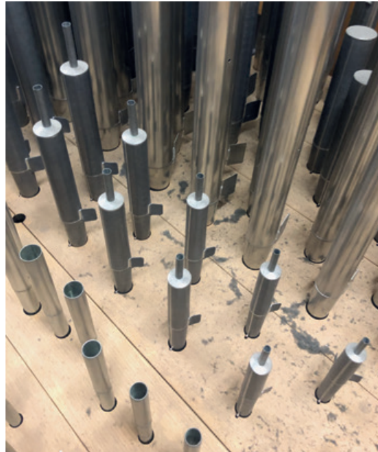
Deutlich sichtbar: der angesammelte Staub
