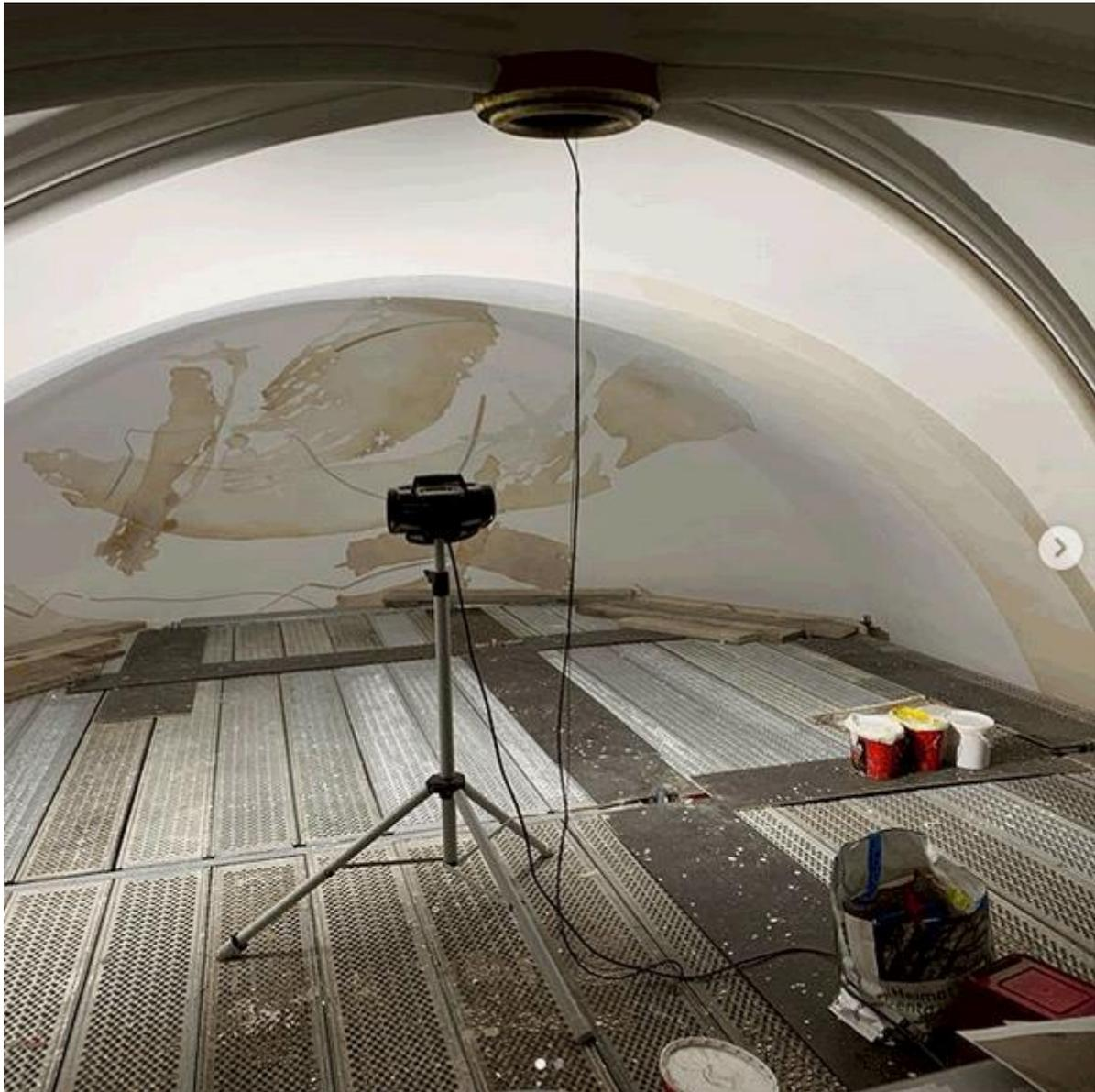
Bis zu 20 einzelne Farbschichten lassen fließende Übergänge entstehen. Die Abbildung zeigt die Conche oberhalb des Verklärungsfensters im Westchor.
